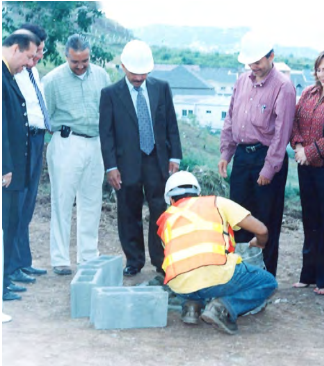
Puesta de primera piedra para la construcción del Edificio Principal de COACEHL, Residencial El Trapiche, Tegucigalpa.
