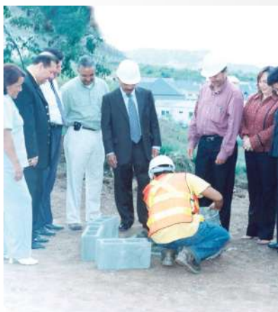
Colocación de la Primera Piedra para la construcción del Edificio Principal de COACEHL, Residencial El Trapiche, Tegucigalpa.
